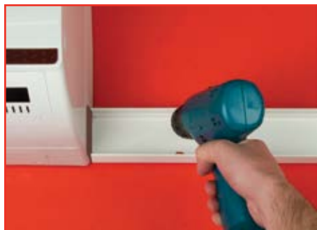
Закрепите основание короба на стене
