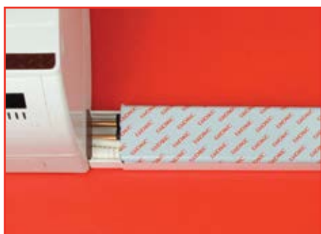
Закройте смонтированную трассу крышкой
