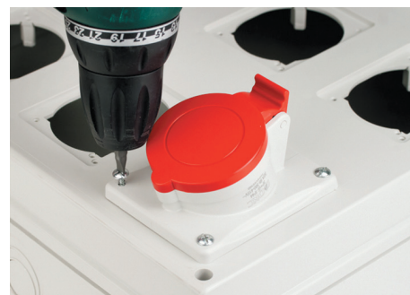
Монтаж розетки на 32 А
